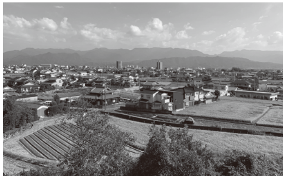
小野地区の全景
