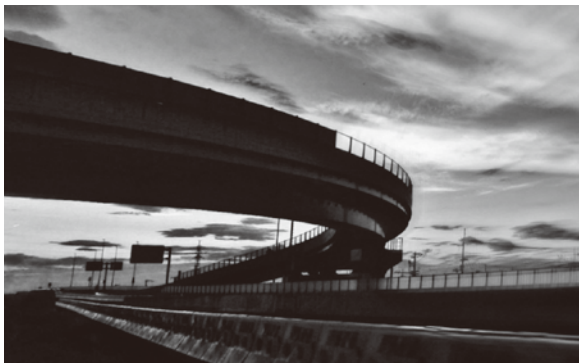
松山インターチェンジの立体交差
