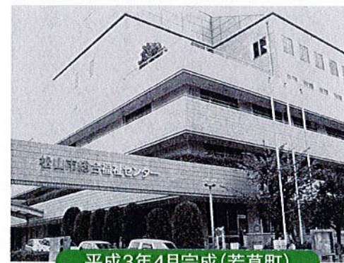
平成3年4月完成(若草町)
