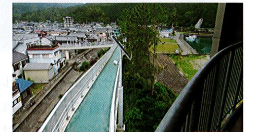
市街地から防災タワーへの避難接続路
