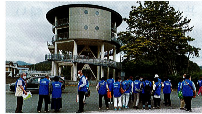
津波避難タワー
