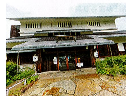
黒潮本陣 40mの高台にあり津波襲来時は 避難所になる
