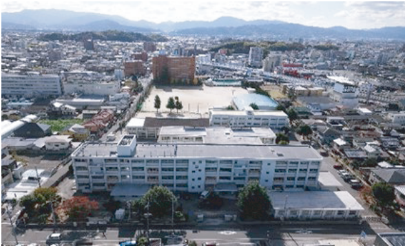
ドローン撮影：拓南中の全景
