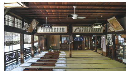
保存修理工事前の道後温泉本館2階の休憩室
