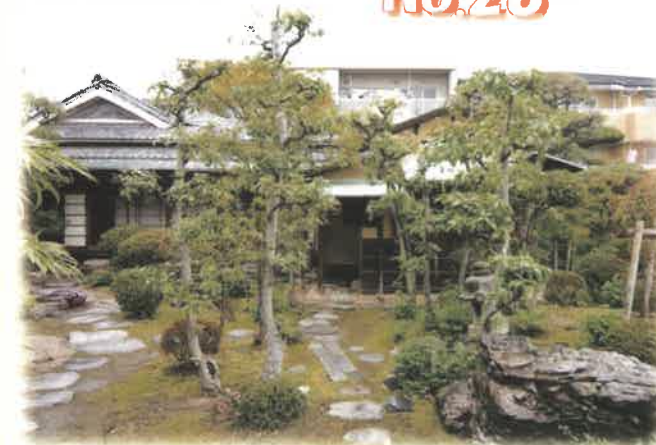
〈母屋全景：南側より〉
